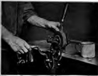
Fig. 224. Agacite Grinder.
